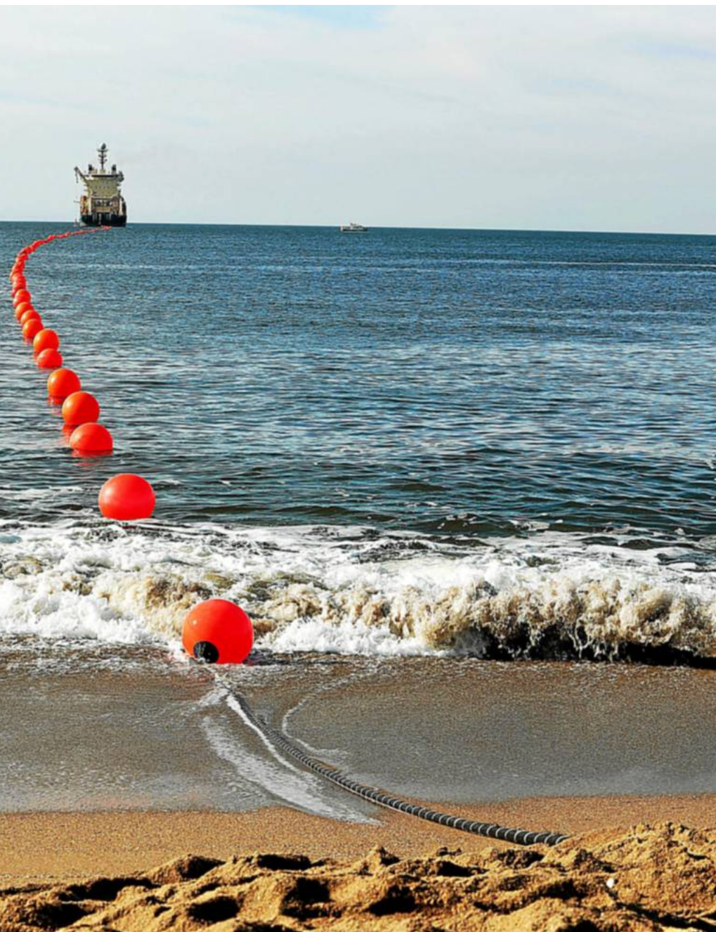
Atterrage, en Uruguay, du premier câble de fibre optique relié aux États-Unis, en 2017. Photo d'archives Raul Martinez/EPA
