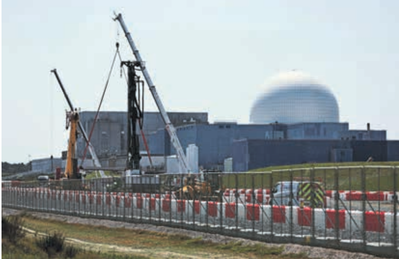
Les travaux préparatoires du chantier de construction des deux EPR de Sizewell C, à Suffolk, dans l'est de l'Angleterre.
